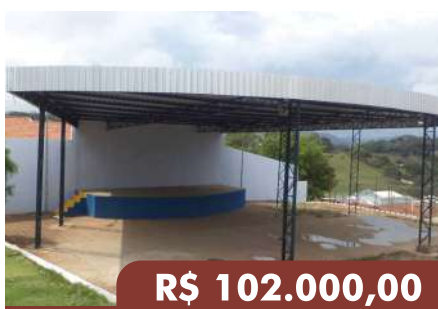
Construção da Cobertura da Praça João Sancho - Popular
