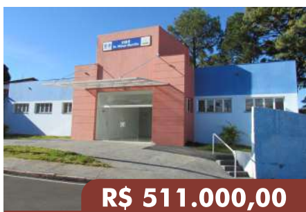
Construção da UBS do Bela Vista
